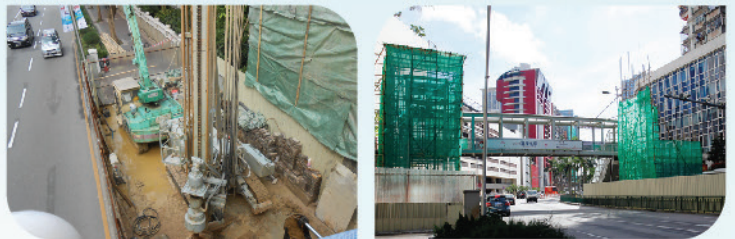
圖：友誼大馬路南方大廈旁行人天橋加建升降機工程
