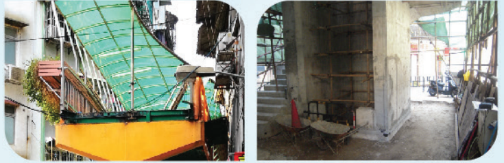
圖：東望洋街行人天橋機電設施改善工程
