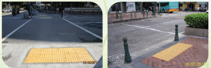
圖：花地瑪堂區無障礙設施改善工程
