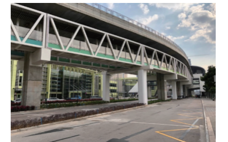
氹仔基馬拉斯大馬路空中走廊建造工程
