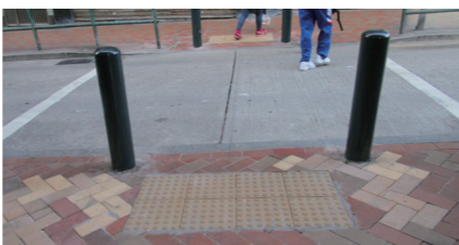
增設公共道路無障礙設施工程(望德堂區)
