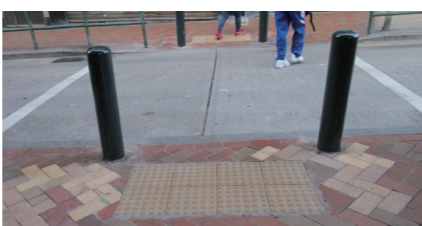
Obra de adição de instalações livres de barreiras em arruamentos públicos (Freguesia de São Lázaro)
