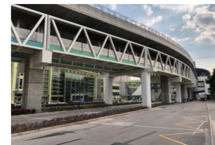
Obra de construção da travessia pedonal ao longo da Avenida de Guimarães na Taipa
